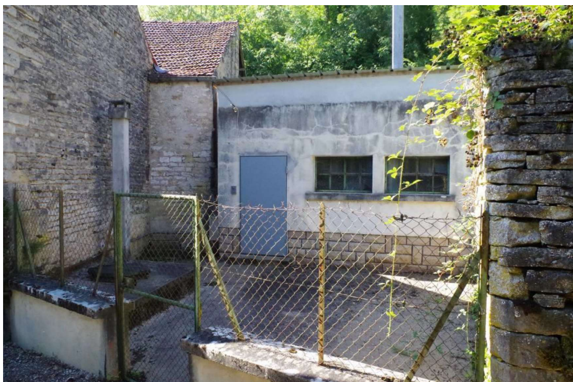
Vue extérieure de la parcelle d'exploitation (Source : SAFEGE 2014)
