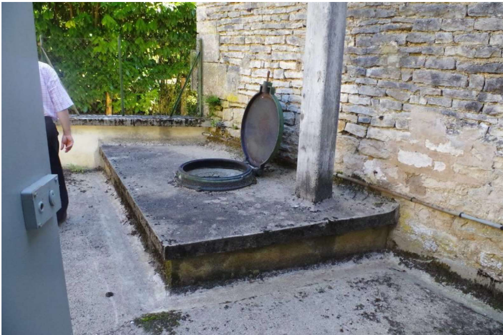
Figure 5 : Vue de l'accès à la chambre de pompage (Source : SAFEGE 2014)
