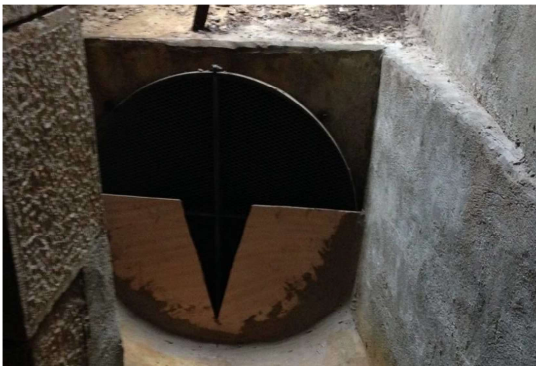
Figure 14 : Suivi du trop-plein du captage « Source de la Fontaine » (source : SAFEGE)
