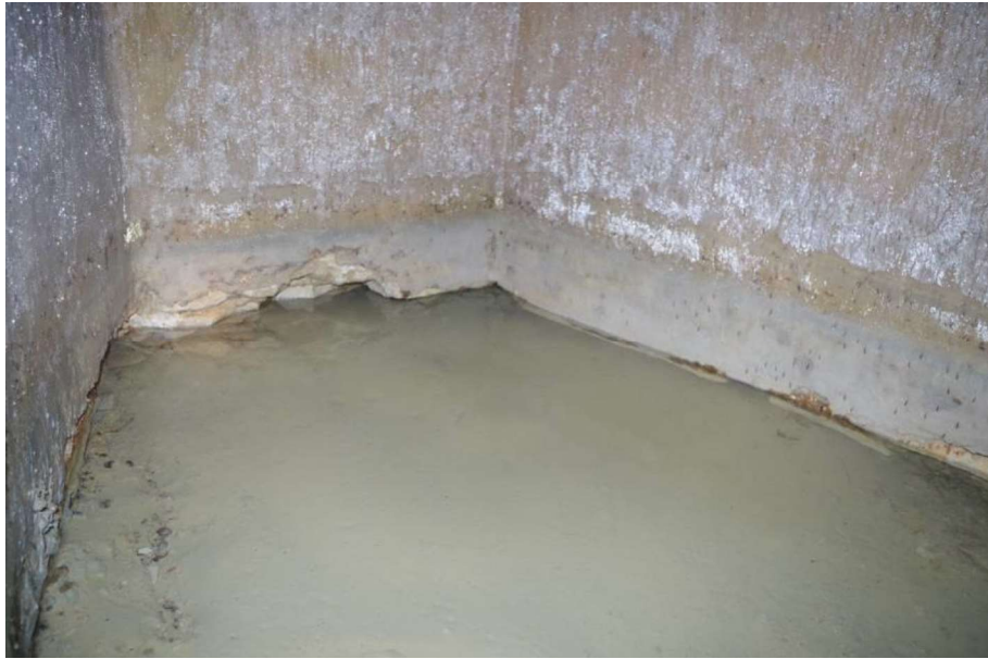
Figure 27 : Vue d'un affleurement des calcaires affleurants de l'Oxfordien et du Kimméridgien inférieur dans la galerie du captage de la source de Sanvigne (Source : SAFEGE)
