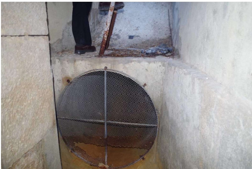
Figure 7 : Vue du trop-plein du captage (Source : SAFEGE 2014)
